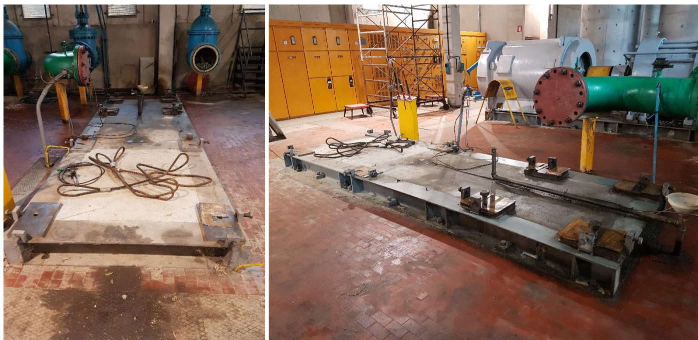
Fig. 4 Vista Basamento Elettropompa da 400 l/s ISI Camastra
