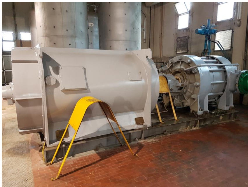
Fig. 2 Vista lati aspirazione e mandata elettropompe da 200 l/s ISI Camastra
