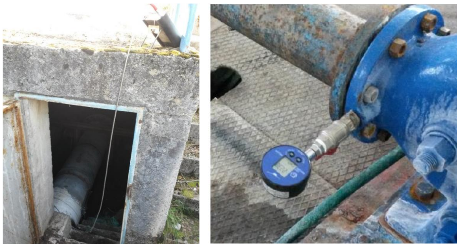
Fig. 7 Misure Portata e Pressione ISI Pietrasasso
